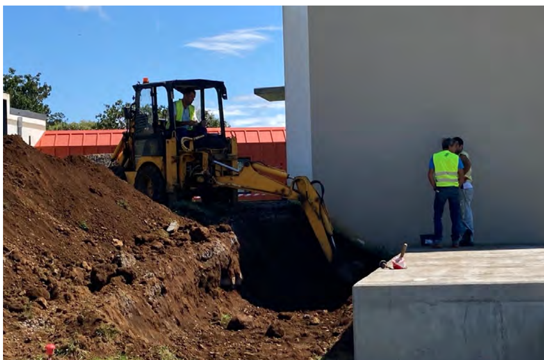
Fig. 13 – Primeiros dias da obra para a instalação do edifício para a DRS e AIR Data Center
